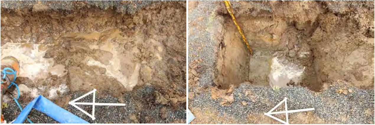
Vasemmallä: AKDG7050:38 Koekaivaus. Koekuopasta 1 esille tulleet kivet. Kuvattu länneä. Kuvaaja Heli Lehto. Oikealla: AKDG7050:40 Koekaivaus. Koekuoppa 1 kaivettuna tavoitesyvyteen. Kuvattu länneä. Kuvaaja Heli Lehto
